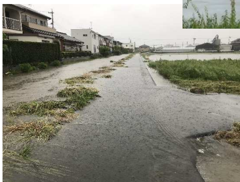
2019年5月21日撮影 安間川まんごく橋上流
