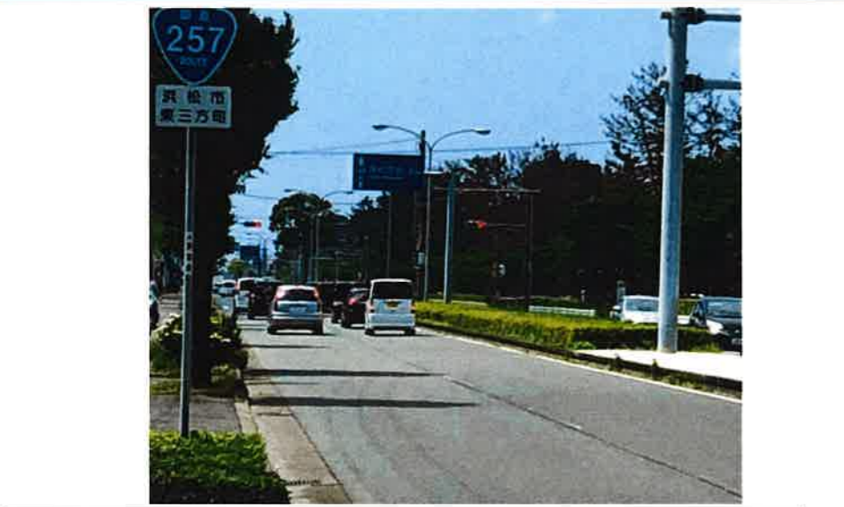
路側線とセンターラインが消えた道路の例。サポカーの「歩行者事故低減ステアリング」は路側帯を歩く歩行者との衝突回避を支援する。歩行者側の白線及び歩行者をカメラで認識して事故を回避するものであり、白線が消えていると機能しない恐れがある。
