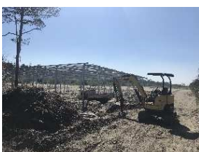
2021年8月28日 田尻町地先 ソーラー設置工事
