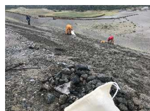
2021年9月26日 中田島砂丘内 防潮堤 崩れ露出した石の清掃
